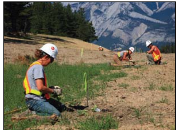
Remise en état de l'emprise dans le parc national Jasper
