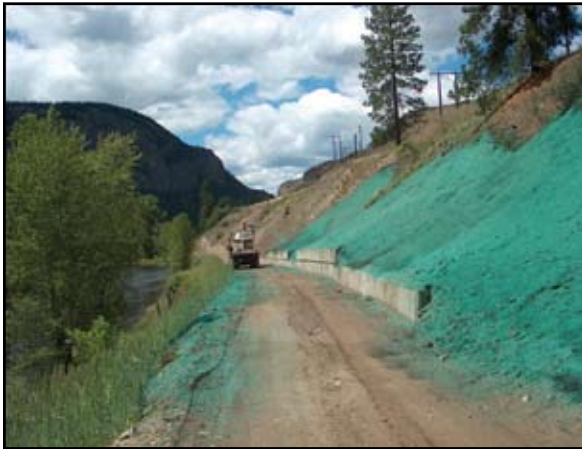
Ensemencement hydraulique
